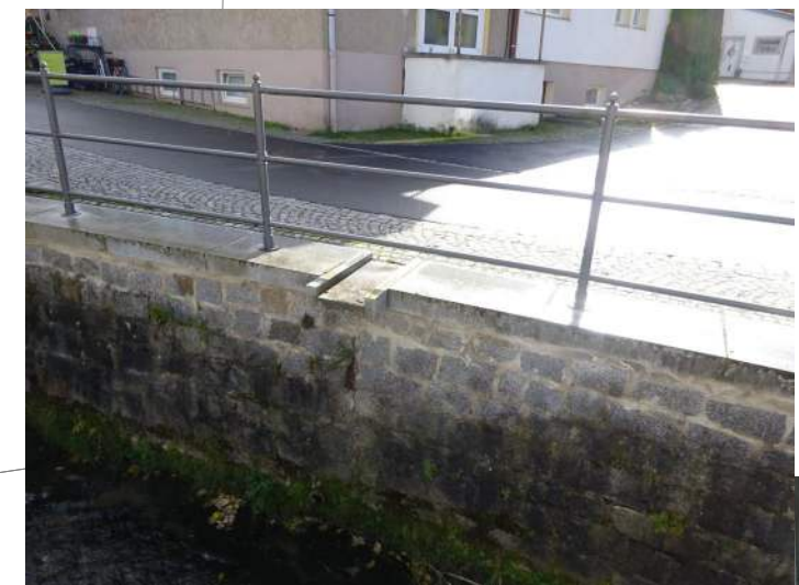
Abdeckung Ufermauer mit Geländer und Wasserspeier
